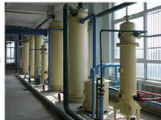
冷凝系统 Condensation system
